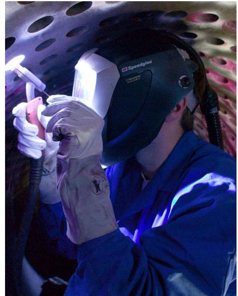
Schweißarbeiten in der Dampftrommel
